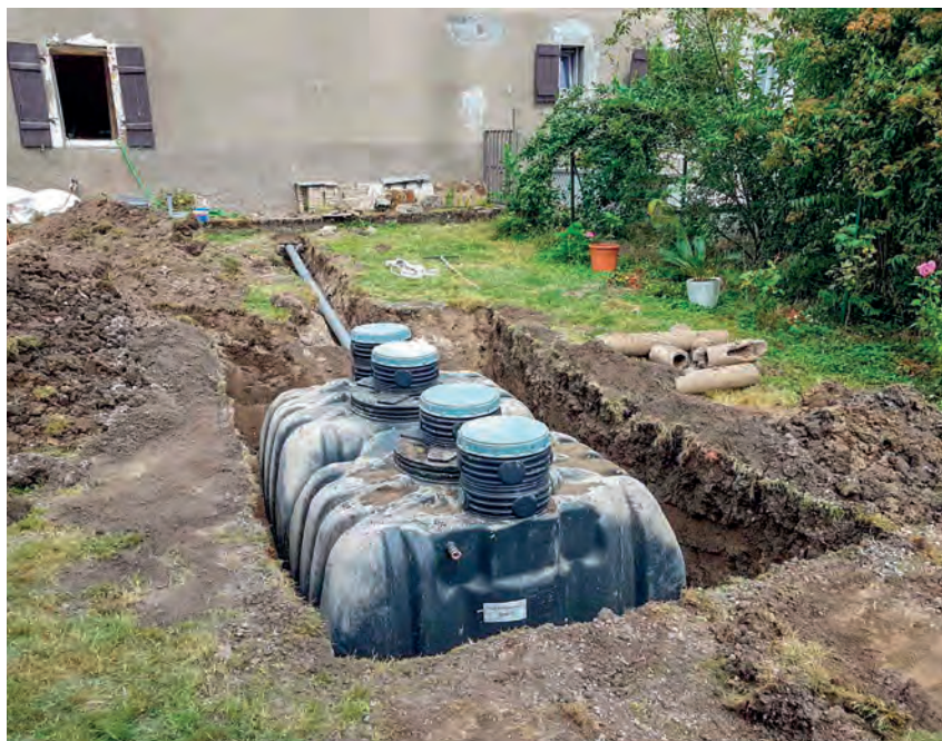
Le filtre compact Brio®, de Stoc Environnement, ne nécessite aucune maintenance spécifique grâce à son média filtrant inaltérable. L'entretien est limité aux opérations de rinçage, réalisables par l'utilisateur lui-même, et de vidange.
