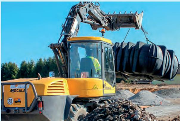
Moins d'une semaine de travail pour équiper la quarantaine d'habitation d'un lotissement en construction avec un système de rétention et de réutilisation d'eau pluviale, c'est la performance réalisée sur le chantier de Geudertheim (Bas-Rhin).
