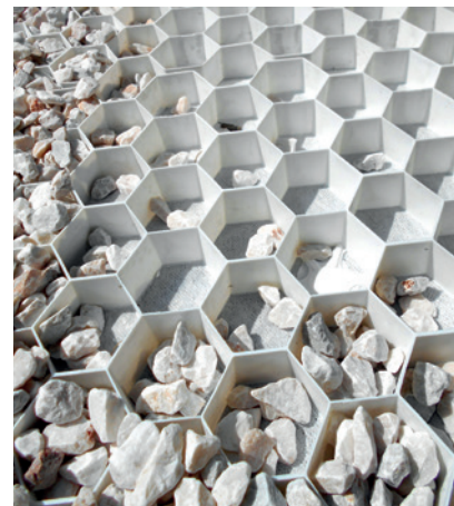
Le Nidagravel consiste dans des dalles alvéolaires utilisées comme stabilisateurs de graviers pour éviter le ruissellement et garantir l'infiltration de l'eau dans le sol.
