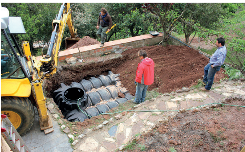
Mise en œuvre chez un particulier d'une cuve de rétention d'eau pluviale de 5 000 l.
