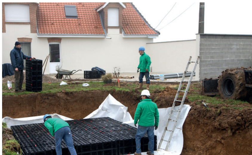
Le kit d'infiltration EP Rainbox 3S est destiné aux constructions neuves ou aux projets d'extension de logements.
