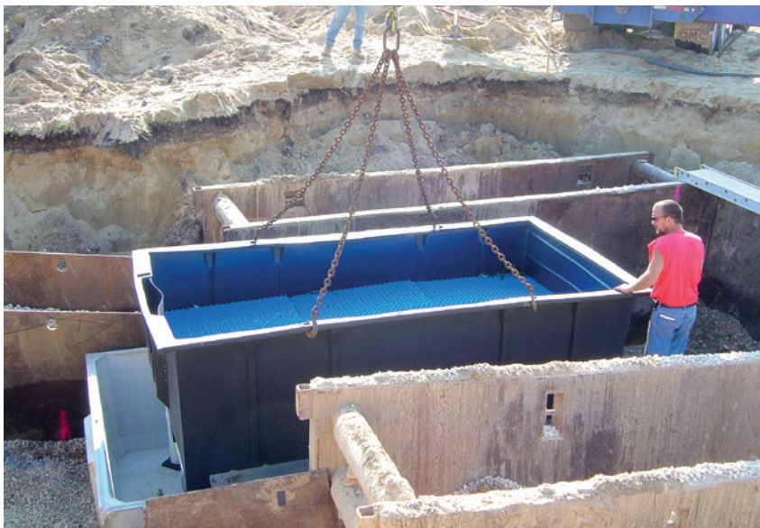
La technologie Biostorm a été conçue pour avoir un taux d'élimination des polluants élevé (+ de 90%).
