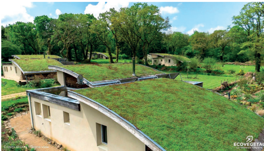
Les toitures végétalisées fonctionnent comme des éponges : elles retiennent une partie des eaux de pluie, qui seront ensuite restituées dans l'atmosphère par évapotranspiration.
