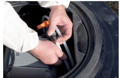
Installer l'ensemble du kit alarme. Dans cette situation, le fonctionnement sur piles est recommandé et doit être privilégié. Une fois le réglage effectué, le boîtier alarme sonore sera placé de telle façon qu'il ne soit pas en contact avec le surpresseur.
