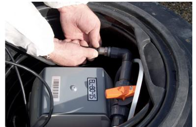
Insérer sur la ligne d'air, le té Ø 14 mm et le morceau de 10 cm de tuyau Ø 14 mm.
