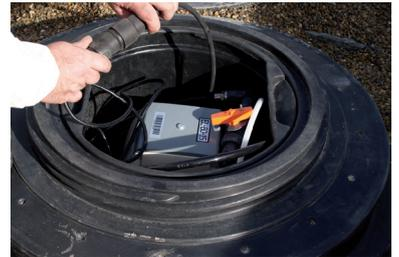
Déconnecter, de l'ensemble bloc vanne, le tuyau d'air Ø 14 mm.
