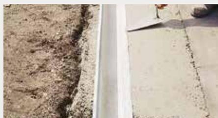
Poser la grille acier ou fonte choisie, selon la résistance souhaitée. Dans tous les cas, attendre une prise suffisante du béton avant de circuler sur le caniveau.
