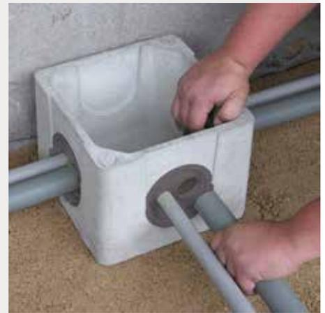
Dans le cas d'une boîte équipée de sa rehausse, pré-coller la boîte avec un joint mastic colle.
