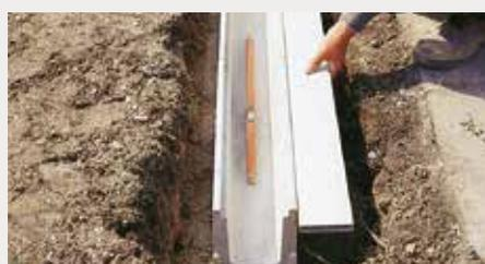
Comblir l'espace entre le caniveau et la tranchée avec du béton. Finir le revêtement avec une surépaisseur de 2 mm au-dessus du caniveau.
