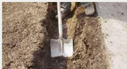
Creuser la tranchée en respectant les dimensions X, Y et Z du tableau ci-contre.
