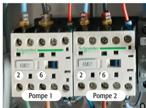
*Nota: Toujours vérifier le bornier supérieur pour mettre en correspondance le câble des pompes sur le bornier inférieur.*
