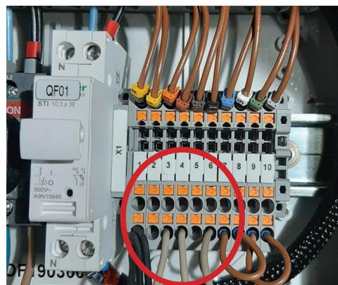
*Nota: En cas de difficulté pour le câblage des 3 fils noirs dans la borne 1, il est aussi possible d'utiliser la borne 2.*
