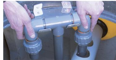
À l'aide du feuillard, remonter la rallonge en tube PVC et la pompe du fond de la cuve.
