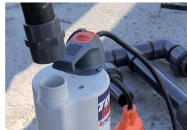
Visser la rallonge tube Ø40 mm sur la pompe et mettre un collier de serrage sur le câble à 3 cm au dessus du raccord de la pompe.
