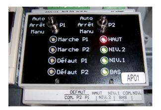
Les régulateurs de niveau sont réglés en usine : si nécessaire, régler leur débattement angulaire. Il est possible de forcer la marche de chacune des deux
